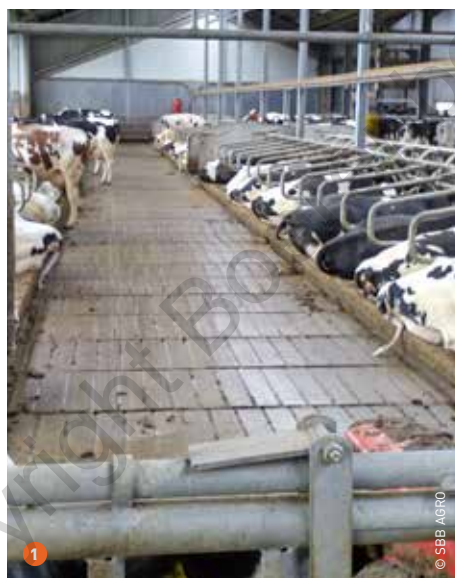
1 De Swaans G2.2-vloer ligt vlak, maar de profilering helt af. 2 Bij de Swaans G6 is een goede mengsmering nodig om de vloer proper te houden.
