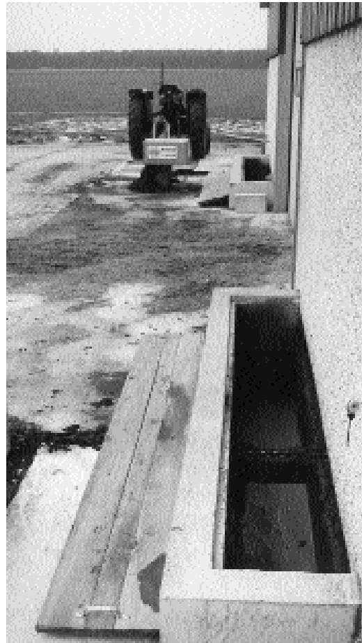
De mest komt via afstorten in een mengkelder terecht.
