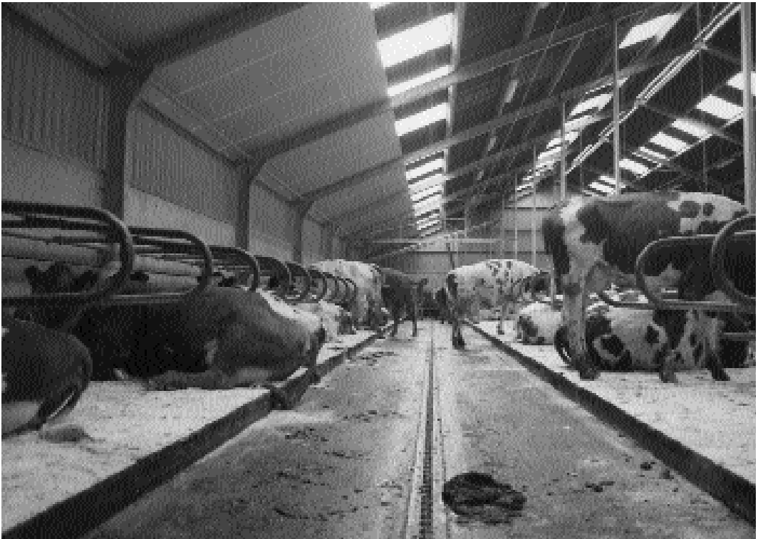
De mestgangen zijn voorzien van hellende vloeren met een giergoot in het midden.
