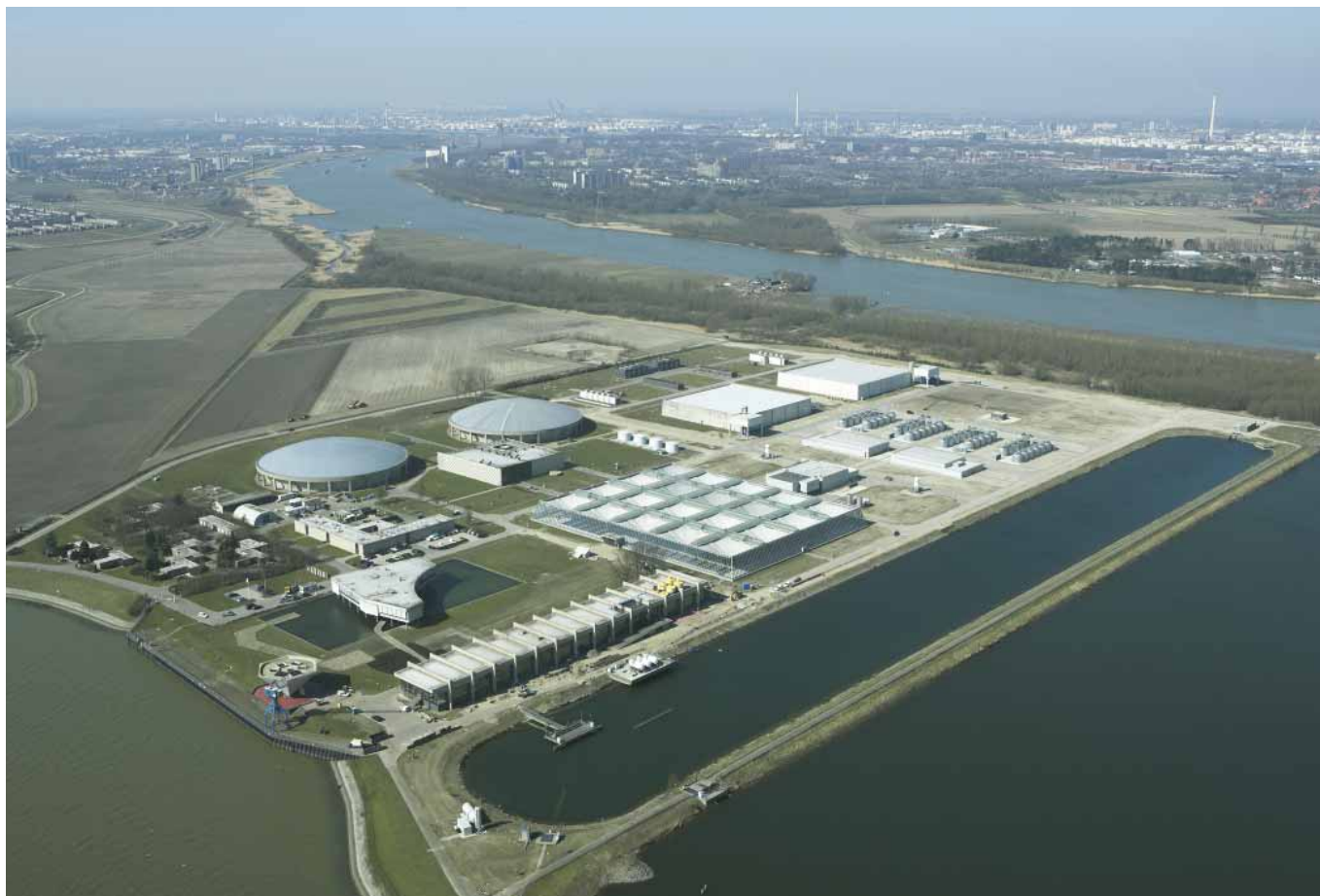
Productielocatie De Berenplaat, van waaruit Evides op 6 april de druktest uitvoerde die leidde tot 15 lekkages in de waterleidingen in Rotterdam en omgeving (foto: Aeroview).
