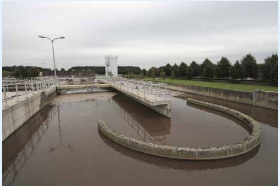
Afvalwaterzuiveringsinstallatie Zeewolde in Zeewolde.
