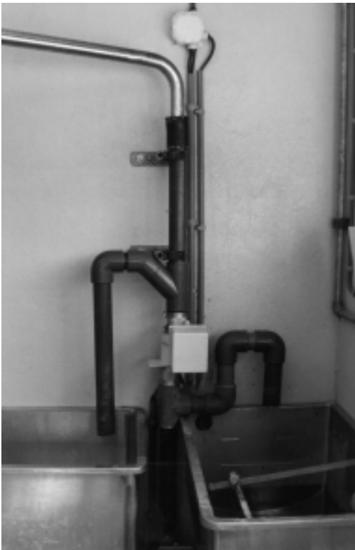
Opvang van naspoelwater in aparte spoelbak (rechts) voor schoonspuiten melkstal
