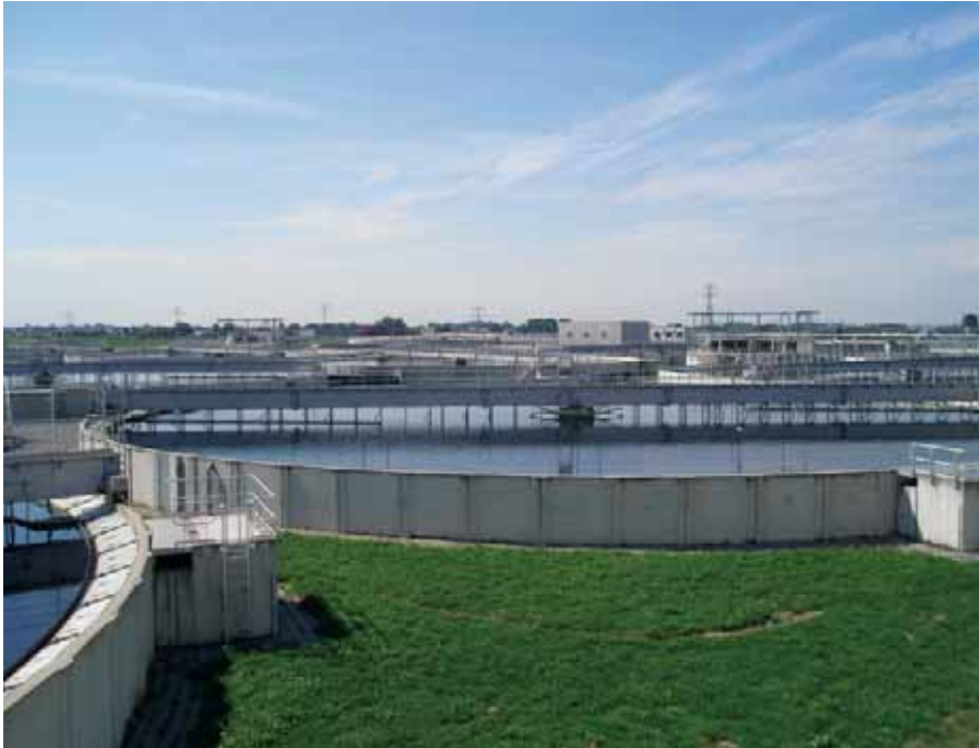
De afvalwaterzuiveringsinstallatie Harnaschpolder bij Den Haag.
