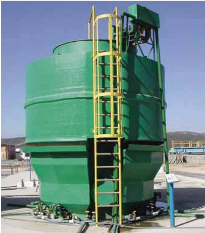
Geïntegreerd compact UASB-oxidatiebedstelsel voor circa 500 i.e. (ontwikkeld in Brazilië).
