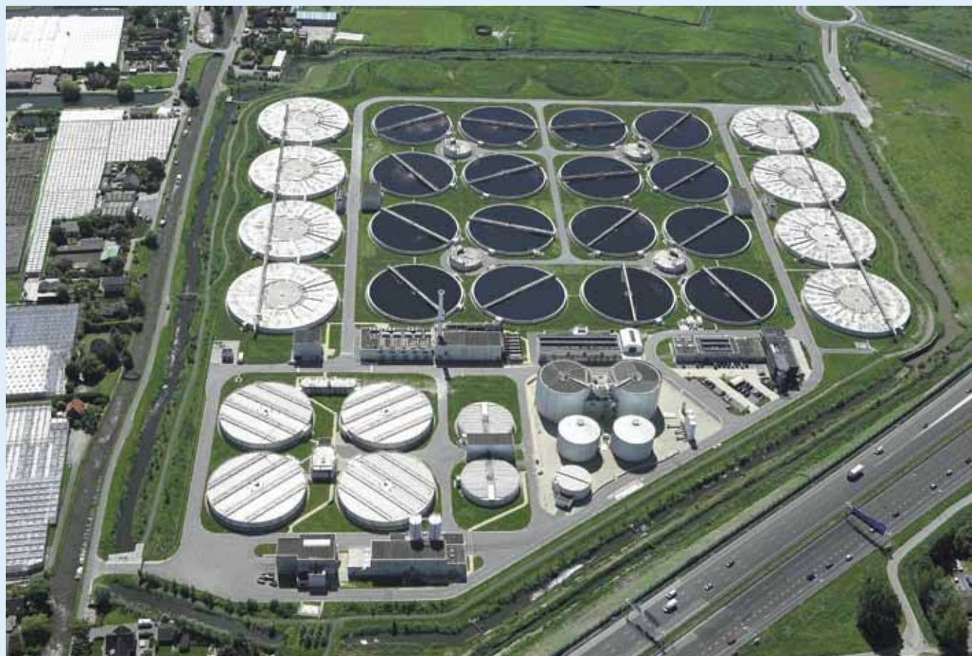
De afvalwaterzuiveringsinstallatie Harnaspolder.
