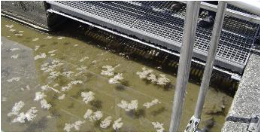
Er is een klein laagje supernatant zichtbaar tussen de pulsmomenten in (rwzi Kaiserslautern).
