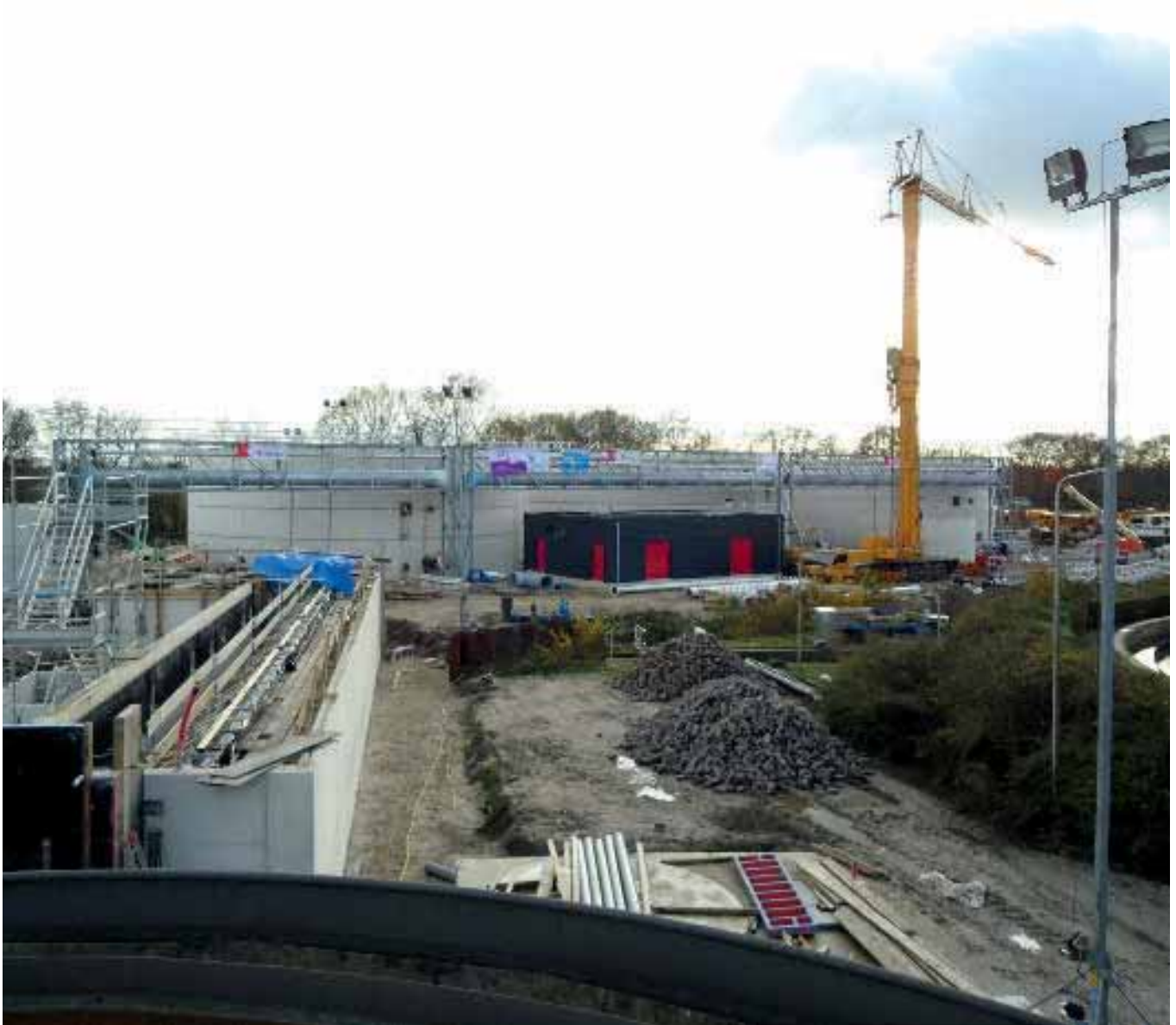
De Nereda-installatie in aanbouw (Waterschap Veluwe).
