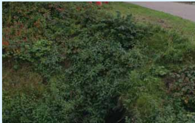
Uitstroomleiding niet meer zichtbaar.
