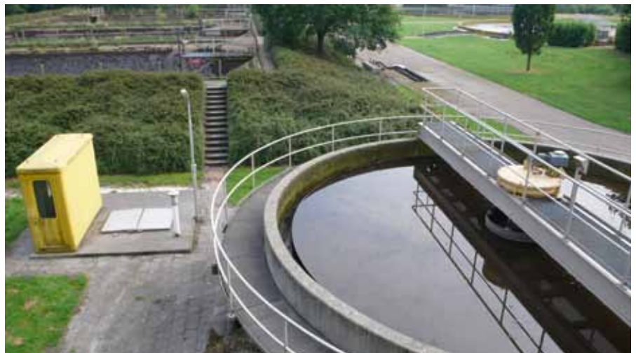
Slibindiker met op de achtergrond slibbuffers.
