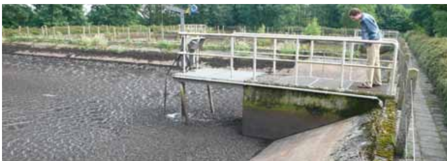
Slibindiker met op de achtergrond slibbuffers.
