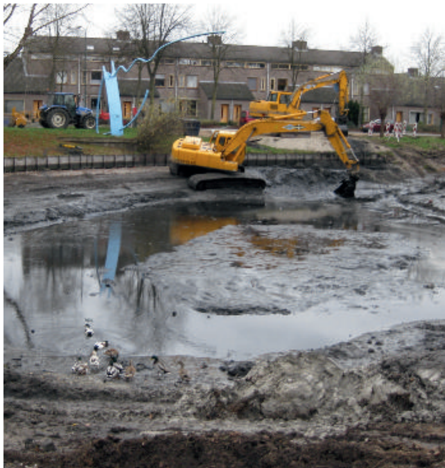
Vijver De Ploeg tijdens het baggeren.
