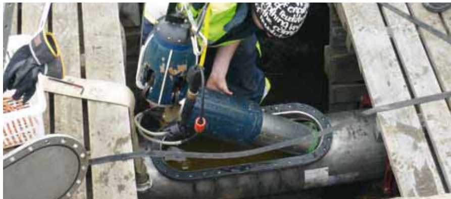
Het inbrengen van de 'torpedo' met de akoestische sensoren in de gietijzeren waterleidingbuis.
