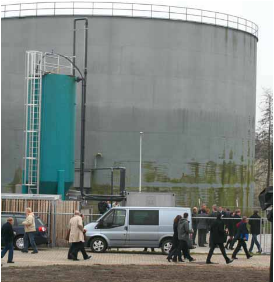
De demonstratielocatie op de rwzi Leeuwarden. Op de voorgrond de blauwe algenreactor. Daarnaast is ruimte voor vier grote zeecontainers of acht normale containers voor technologisch onderzoek.
