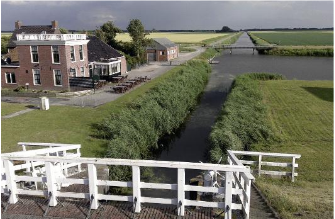
De Noordpolder, gezien vanaf het gemeal aan de waddendijk.
