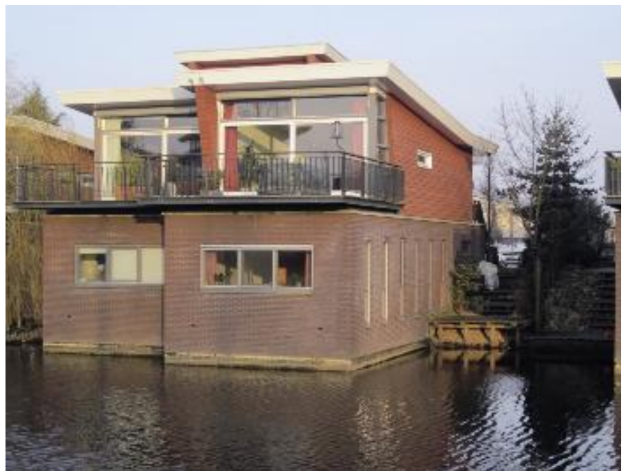
Woning half in het water in Amersfoort (Nieuwland).
