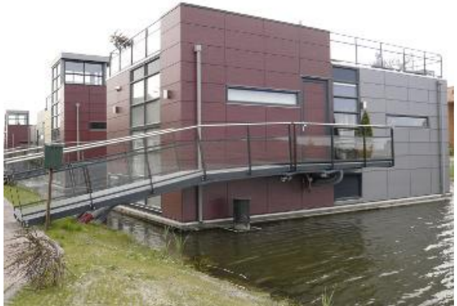
Drijvende woning aan de vaste wal in Utrecht (Terwijde).
