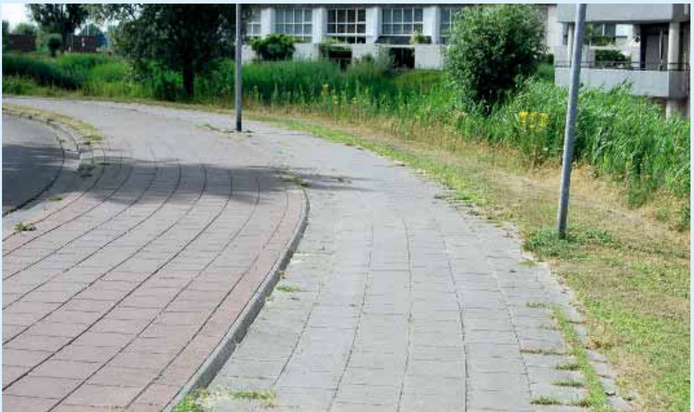
Hemelwater afvoeren naar de berm in plaats van kolken.
