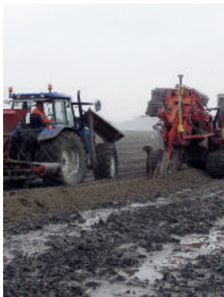
Proefopstelling met omhulde drains in Noordhoek: a) Aanleg van omhulde drain, b) Sleuf met drain en mengsel van houtsnippers en zand, c) Proefopstelling met verzameldrains.
