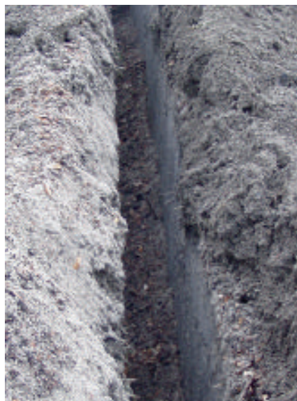
Proefopstelling met omhulde drains in Noordhoek: a) Aanleg van omhulde drain, b) Sleuf met drain en mengsel van houtsnippers en zand, c) Proefopstelling met verzameldrains.
