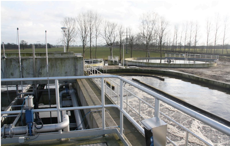
Afbeelding 1. De hybride Nereda-installatie in Vroomshoop (links: Nereda, rechts: CAS)
