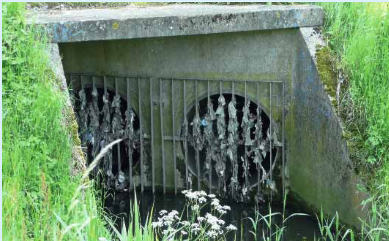
Een riooloverstort (foto: Jeroen Langeveld).
