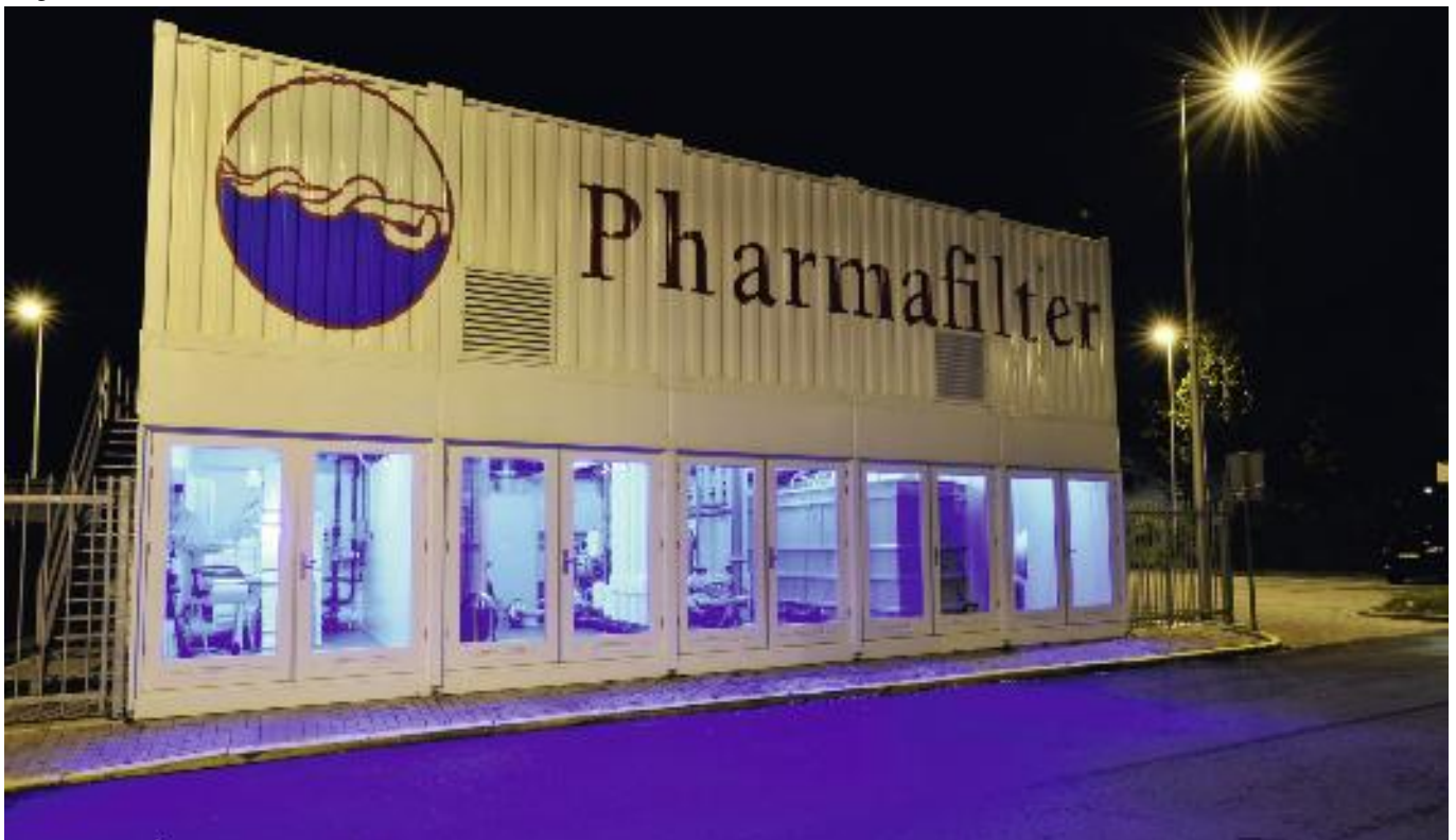
Het gebouw van Pharmafilter in Delft.
