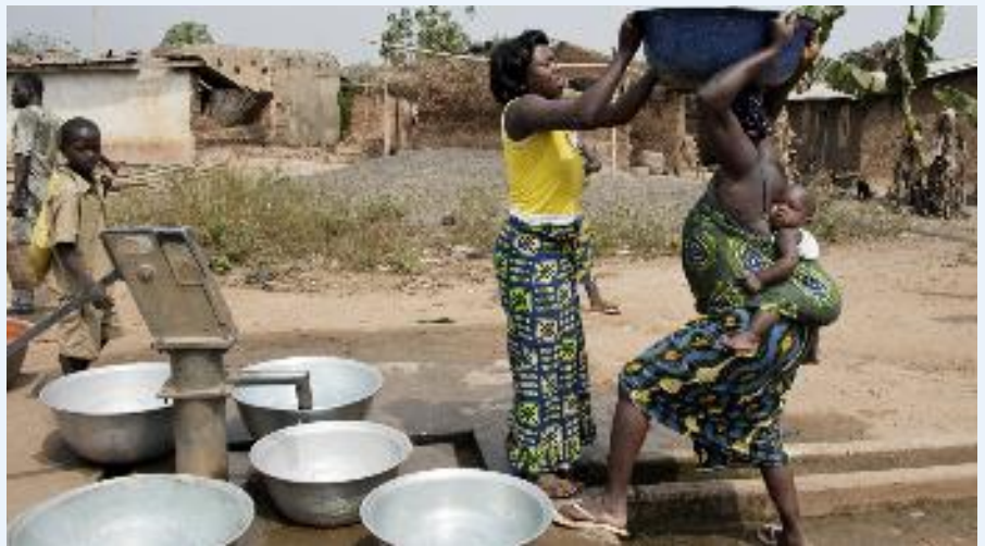
In kleinere dorpen zijn Mark III-pompen geplaatst.
