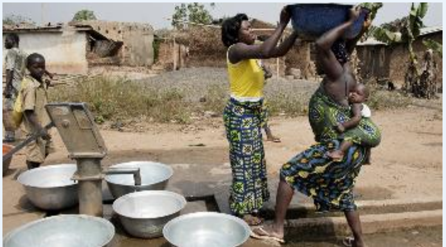
In kleinere dorpen zijn Mark III-pompen geplaatst.
