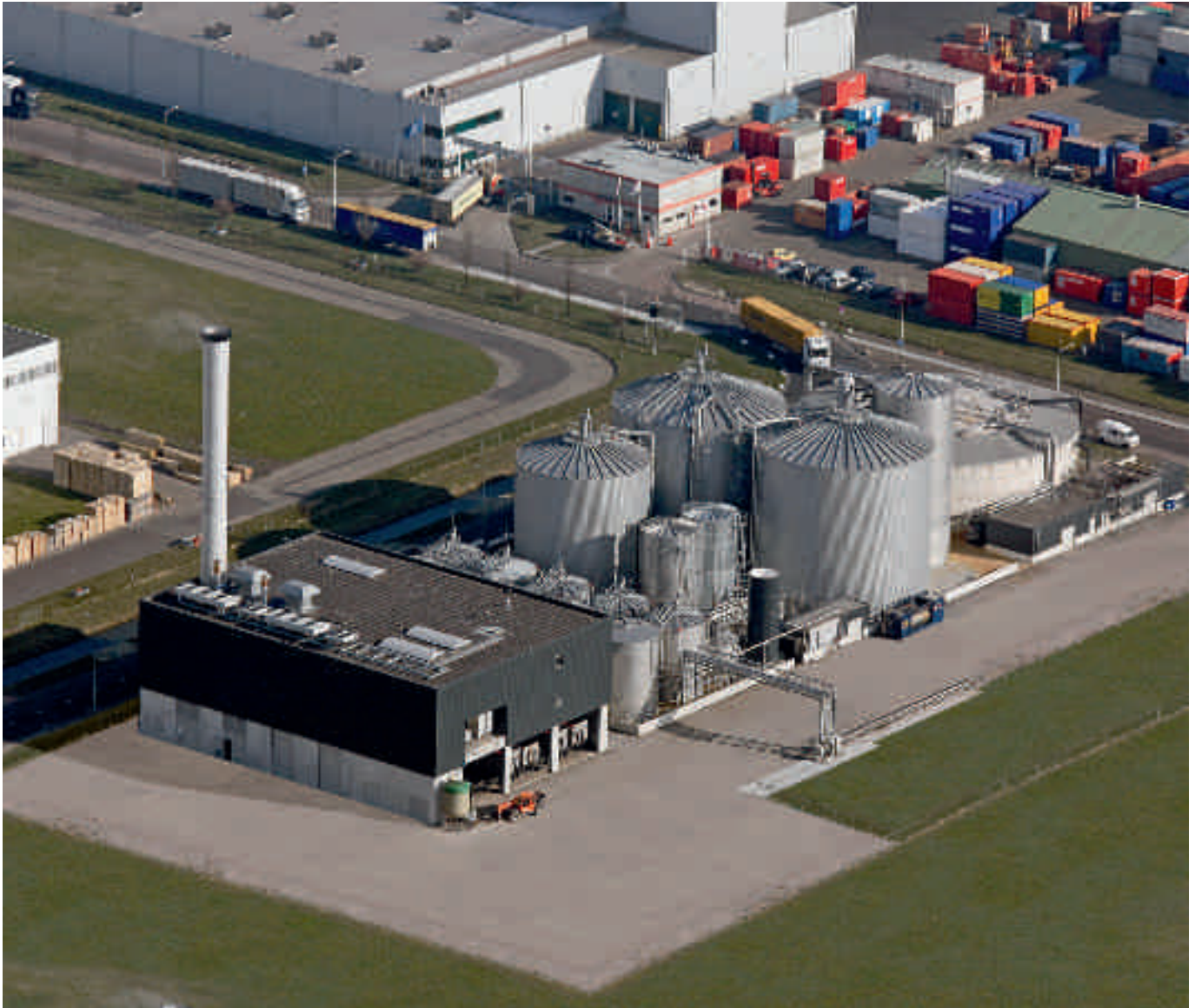
De zuiveringsinstallatie Greenmills in Amsterdam, met de kleine en de twee grote reactoren (foto: Orgaworld).
