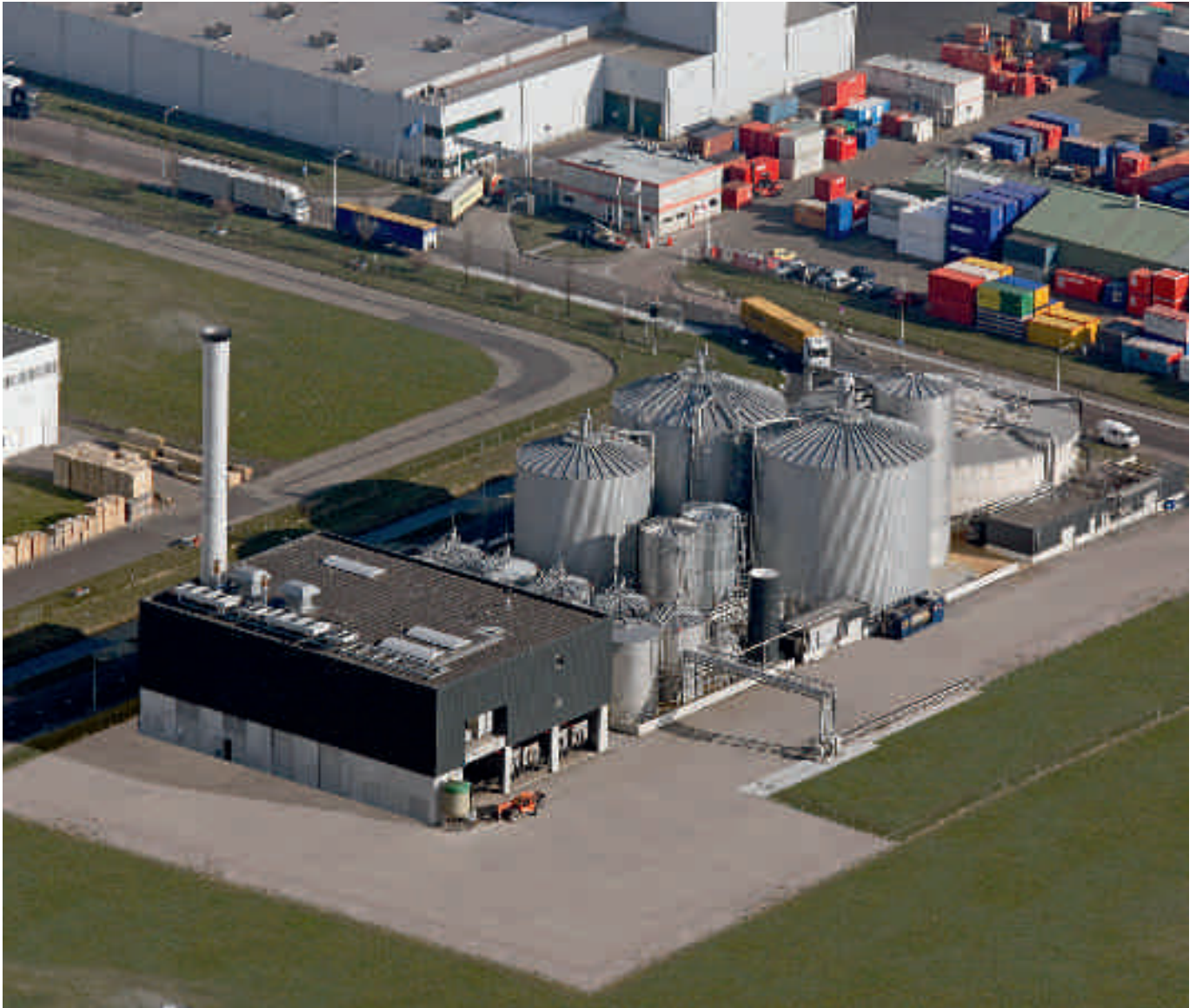
De zuiveringsinstallatie Greenmills in Amsterdam, met de kleine en de twee grote reactoren (foto: Orgaworld).
