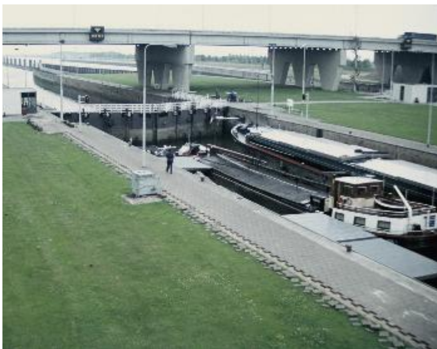
Sluisschutting in Volkeraksluizen.
