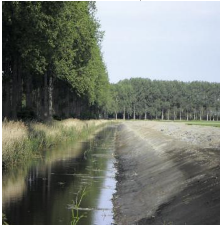
Voorbeeld van een duurzame oever: 30 cm diep en een 1,5 meter brede plasberm.
