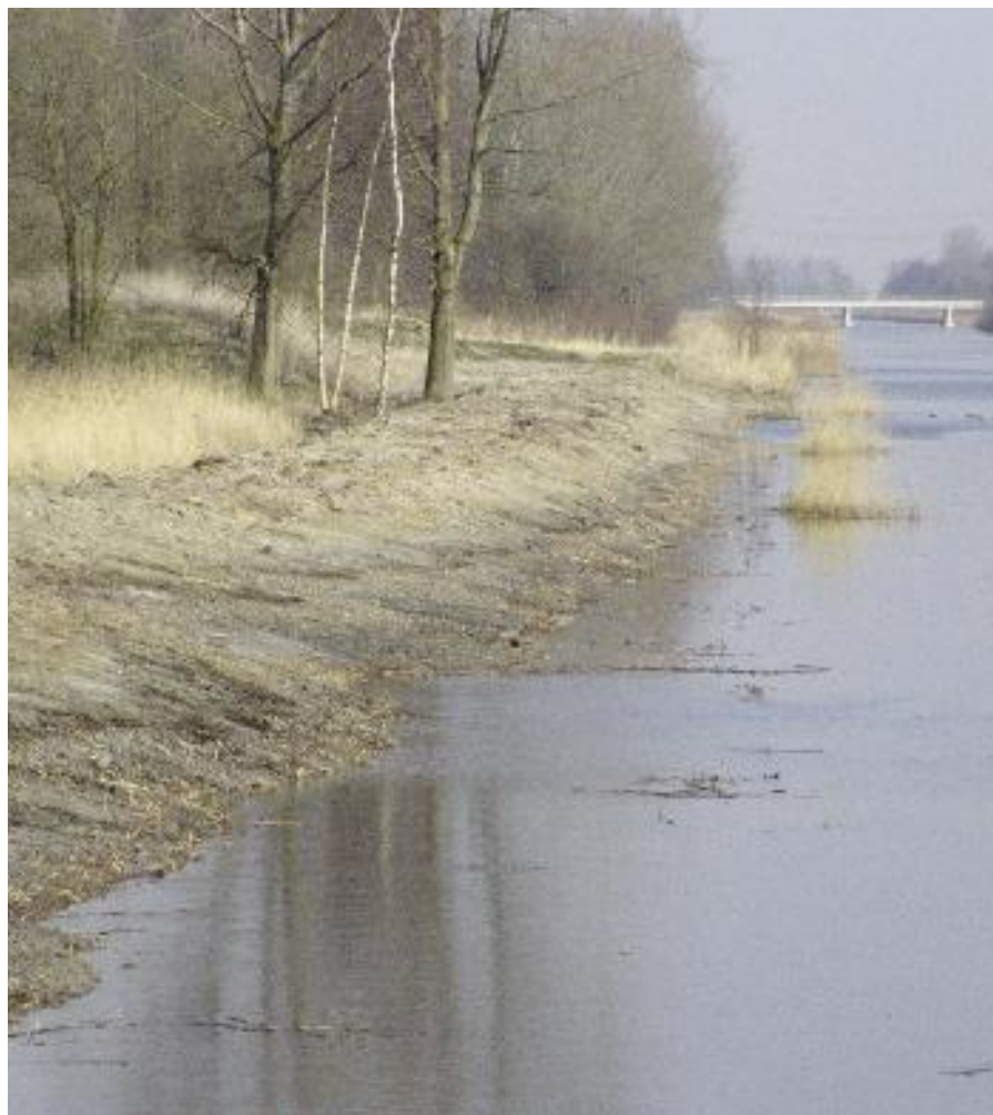
Voorbeeld van een natuurvriendelijke oever: variabel wat ontwerp en grootte betreft, maximaal 80 cm diep en 1,5 tot 10 meter breed.
