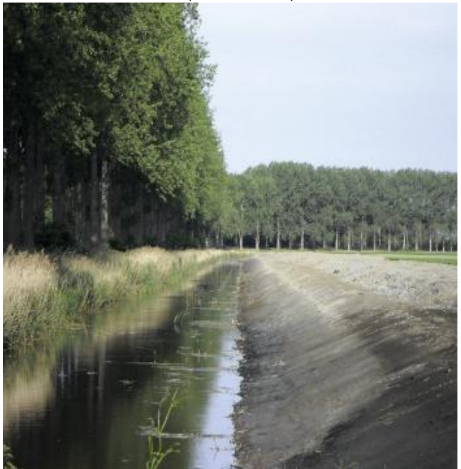
Voorbeeld van een duurzame oever: 30 cm diep en een 1,5 meter brede plasberm.
