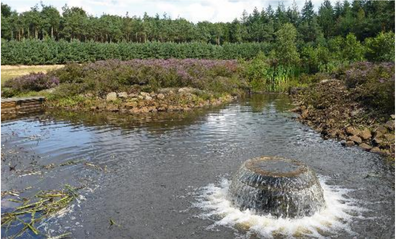
Infiltratievijver in Epe.
