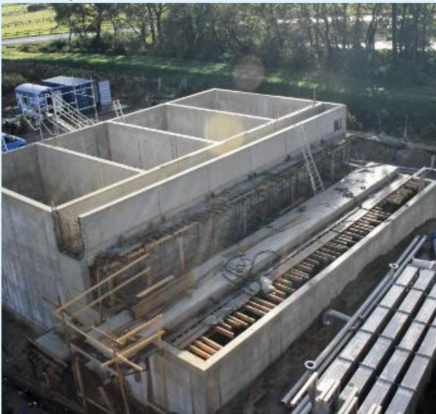
De nabehandelingsinstallatie in aanbouw.
