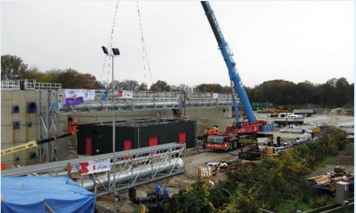
Plaatsing van de leidingbrug voor de drie Nereda-reactoren in Epe.
