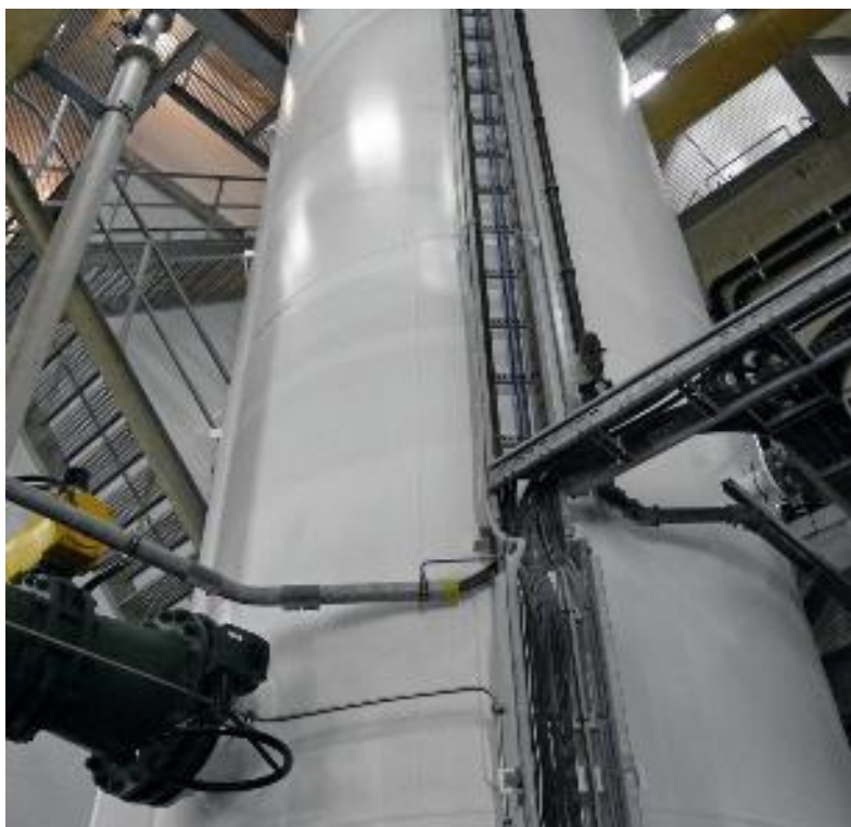
Full scale onthardingsreactor van WML (IJzeren Kuilen).
