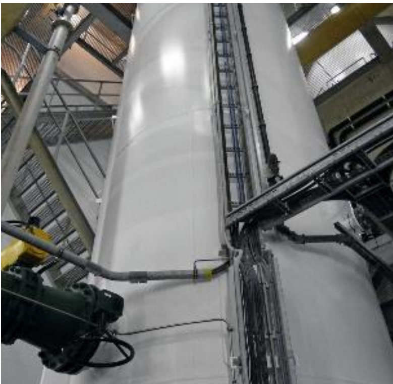
Full scale onthardingsreactor van WML (IJzeren Kuilen).
