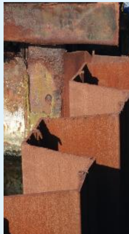
Oude en nieuwe damwanden.
