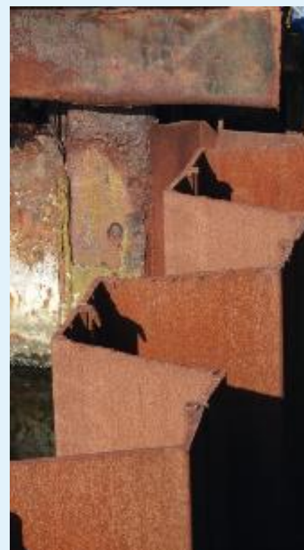
Oude en nieuwe damwanden.
