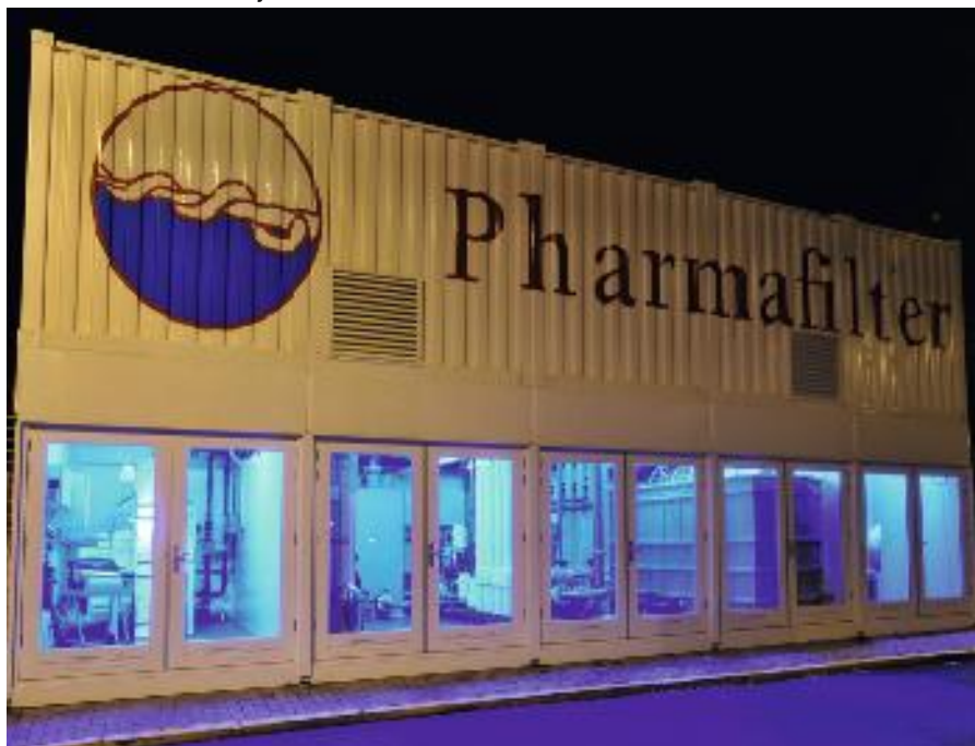
De Pharmafilter installatie bij het Reinier de Graaf ziekenhuis in Delft.
