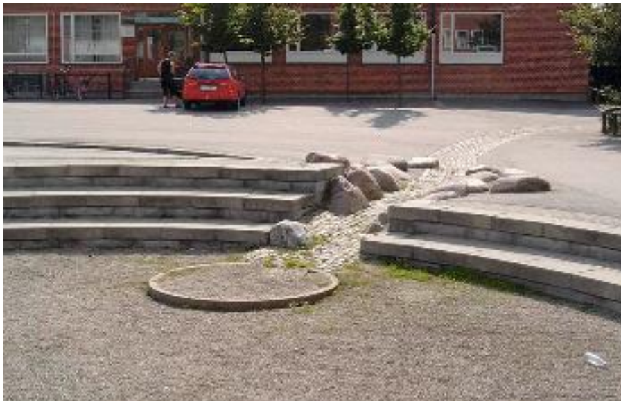
Een speelplaats in Malmö (Zweden) dient ook als waterberging.
