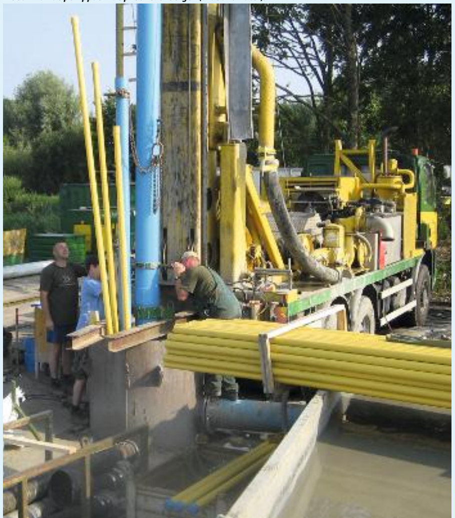
Inbouw van de pompput in de pilot Zevenbergen (Brabant Water).
