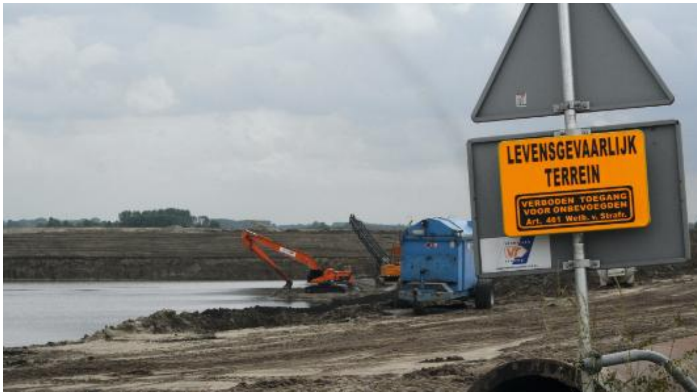
Het afgraven van grond in de Overdiepse Polder.
