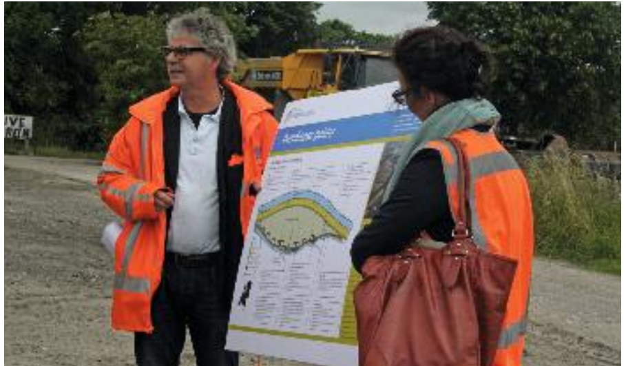
De 550 hectare grote Overdiepse Polder zorgt straks bij het onder water lopen voor een peilverlaging van 27 cm. De in totaal acht terpen aan de zuidzijde blijven veilig en droog.
