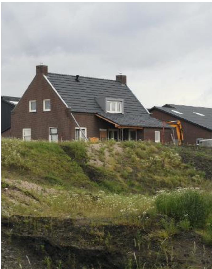
De eerste nieuwe boerderij op een opgeworpen terp in de Overdiepse Polder.
