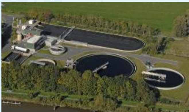
De rioolwaterzuiveringsinstallatie van Burdaard.
