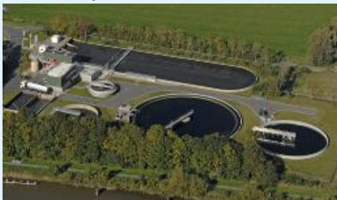
De rioolwaterzuiveringsinstallatie van Burdaard.
