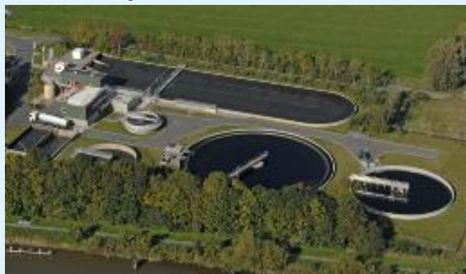
De rioolwaterzuiveringsinstallatie van Burdaard.
