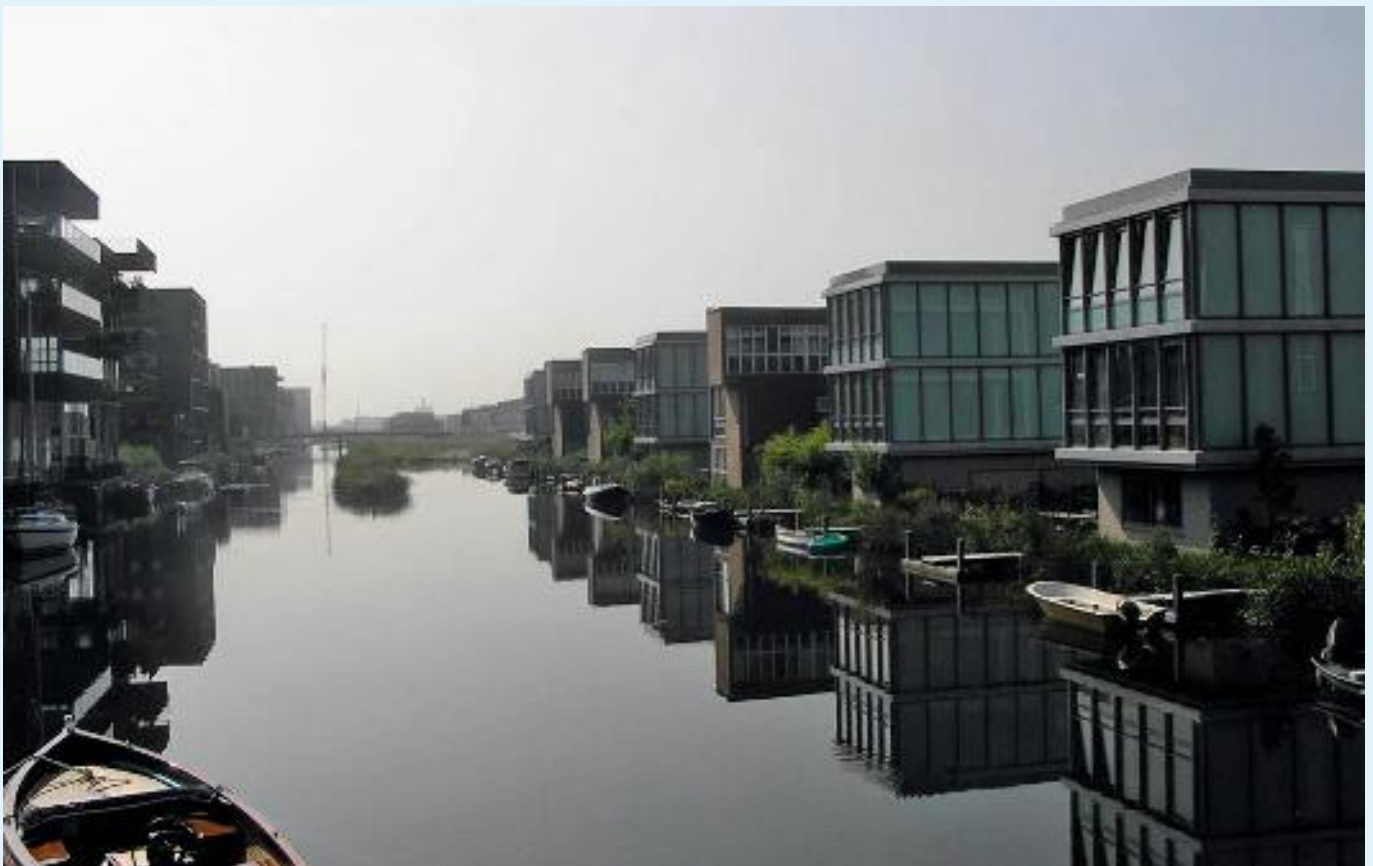
Waterwoningen in Amsterdam (IJburg).
