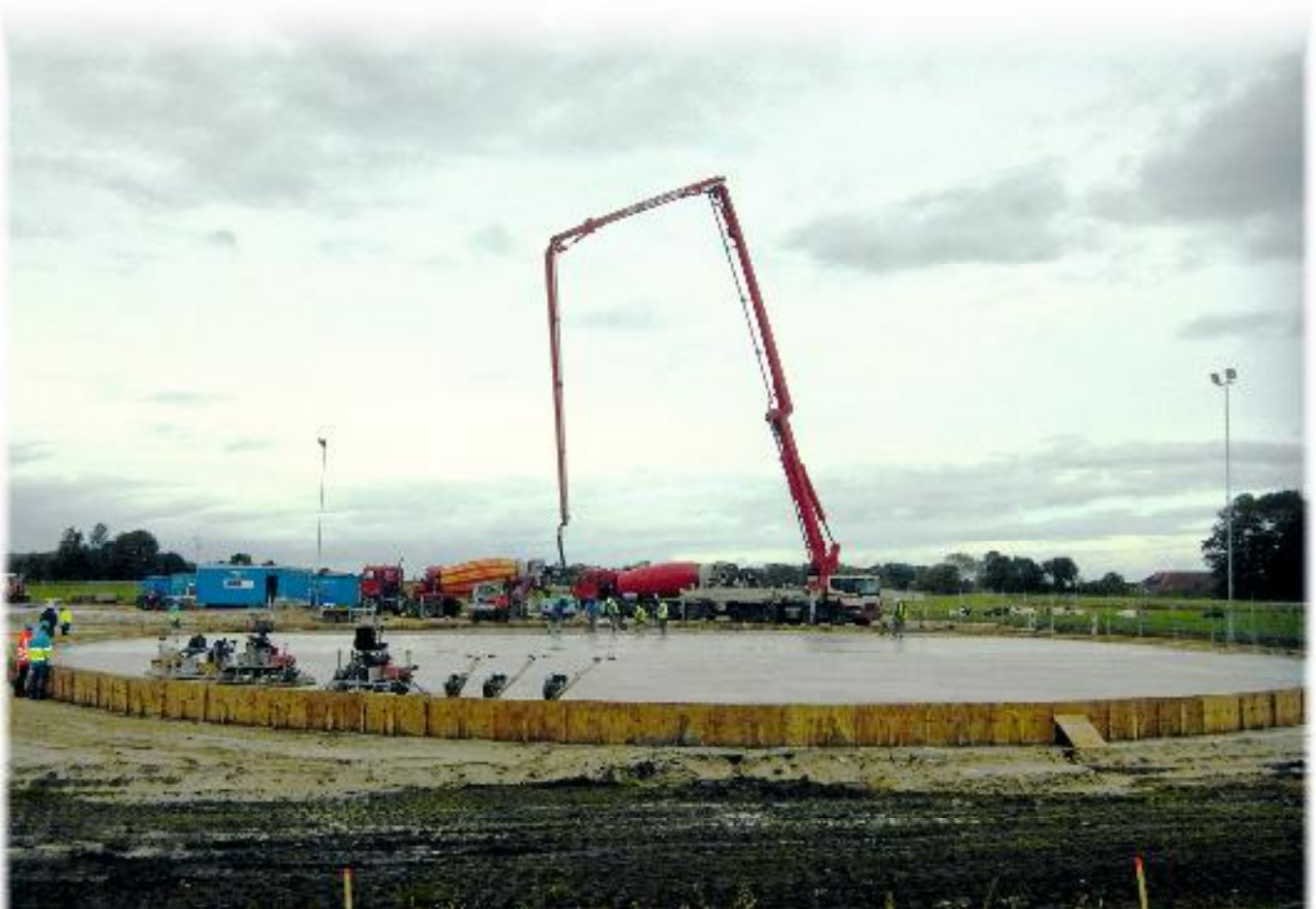
Het storten van de vloer van één van de nieuwe Nereda-reactoren (foto: Gerrit Boonzaaijer).
