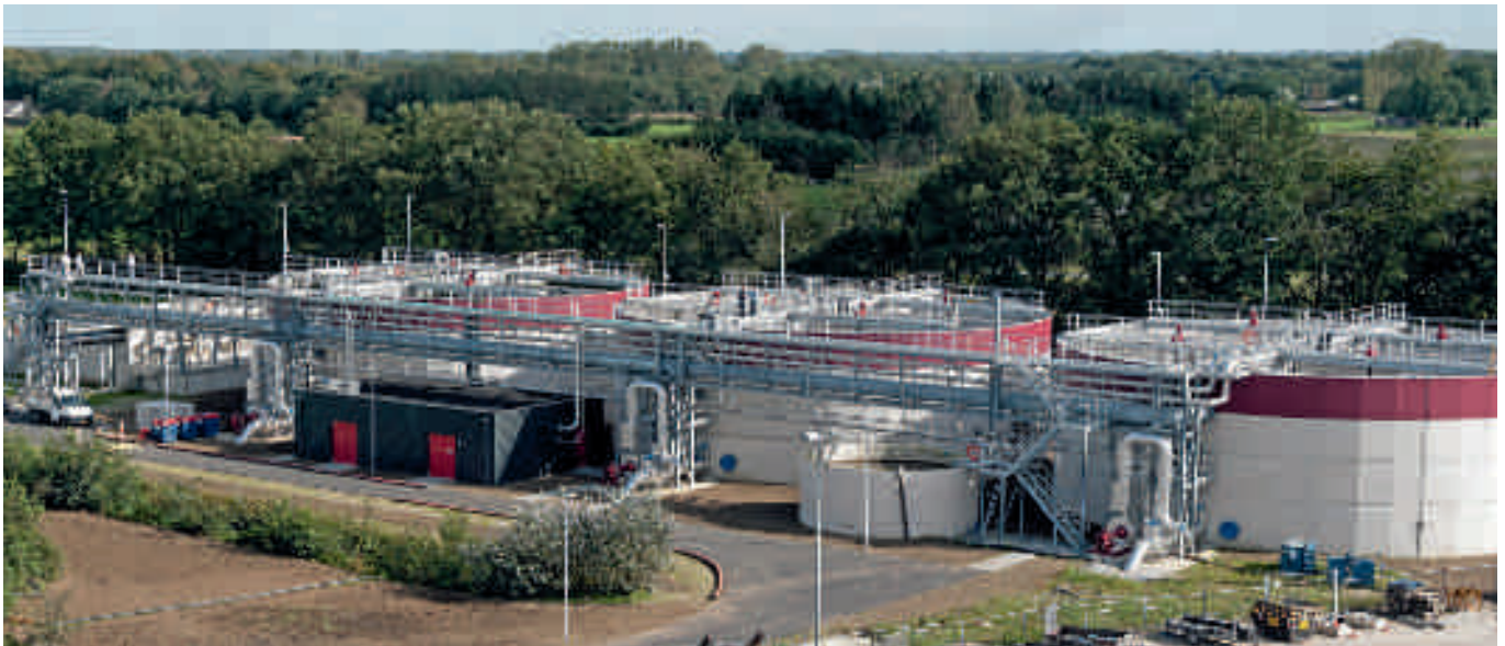
De Nereda-installatie op rwzi Epe.
