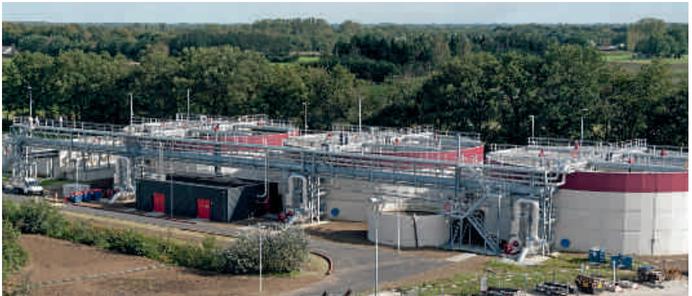
De Nereda-installatie op rwzi Epe.
