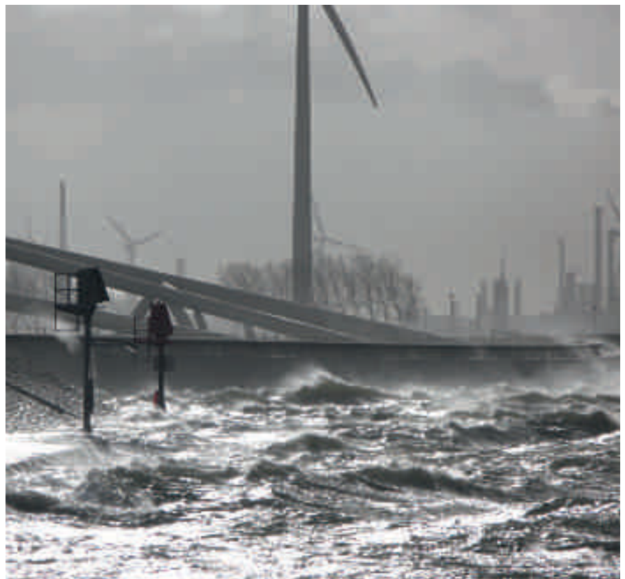
De gesloten Maeslantkering tijdens een storm in 2008.
