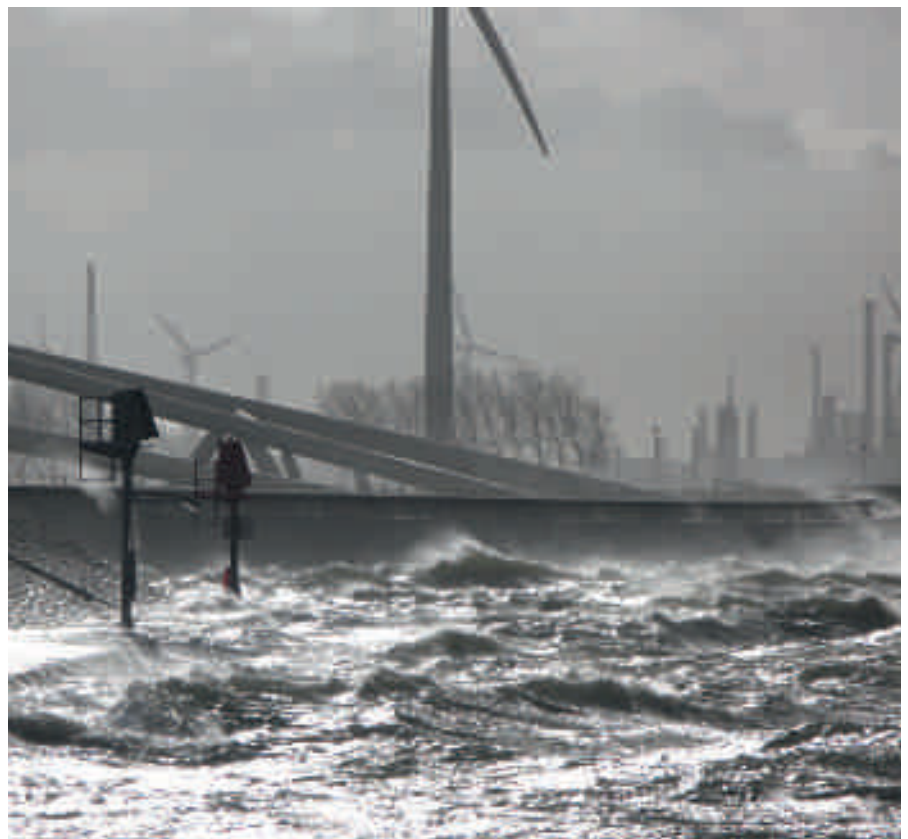
De gesloten Maeslantkering tijdens een storm in 2008.
