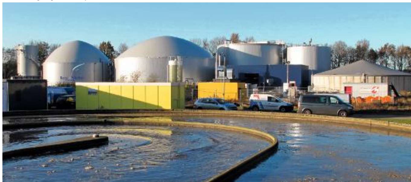
De nieuwe slibgistingsinstallatie op de rwzi in Echten.
