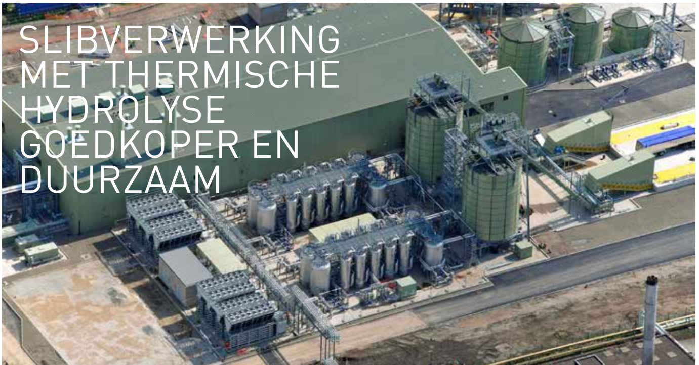
(Cambi-)installatie voor thermische hydrolyse op de centrale slibverwerking Davyhulme (Manchester). Deze heeft een verwerkingscapaciteit van 120.000 ton drogestof per jaar
