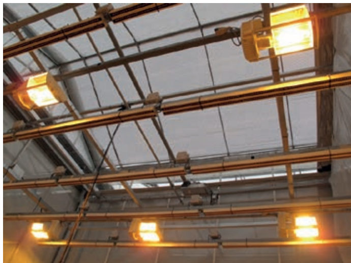
Foto 1 Combinatie SON-T en verrode LED belichting.
