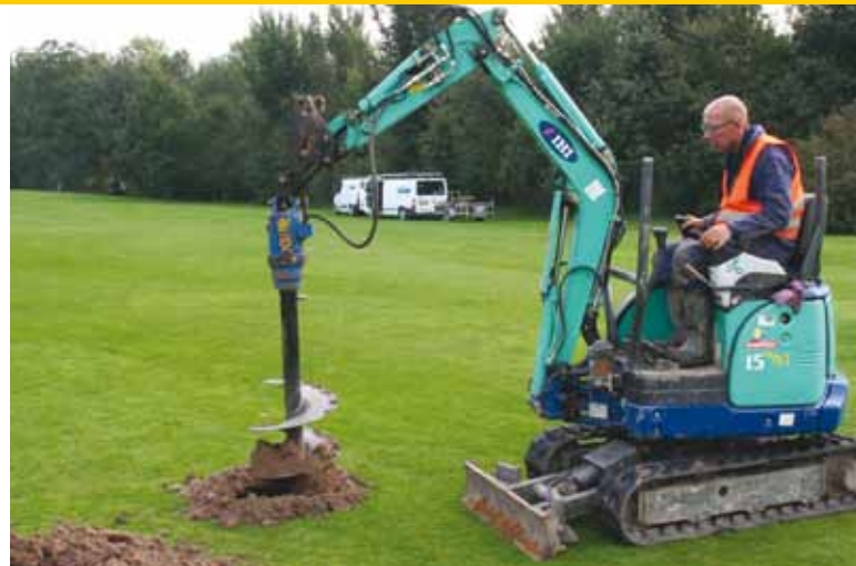
Graafwerk ten behoeve van sproeier in de fairway.
