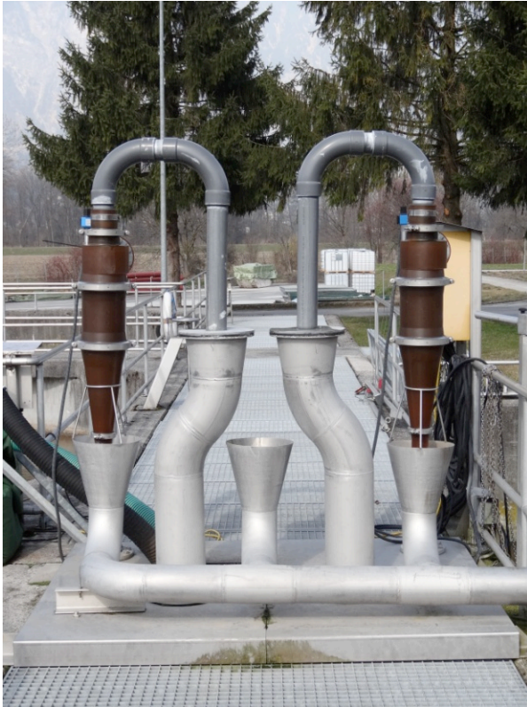
Afbeelding 6. cyclonen in de surplussliblijn van RWZI Strass
