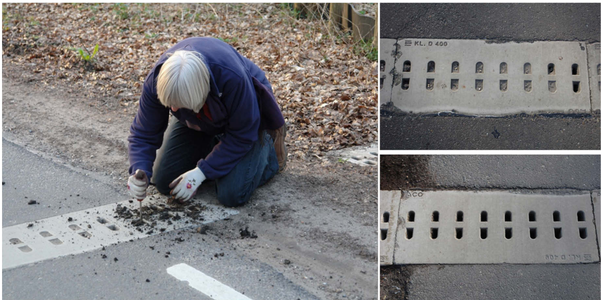
Figuur 8 Op de linker foto is te zien hoe een vrijwilliger van de paddenwerkgroep Hora est de dichtgeslibde gaten in de bovenzijde van de tunnel weer openmaakt, zodat de tunnel weer aantrekkelijker wordt voor gewone padden en bruine kikkers. Rechtsboven de dichtgeslibde variant en rechtsonder na uitvoering van onderhoud.
