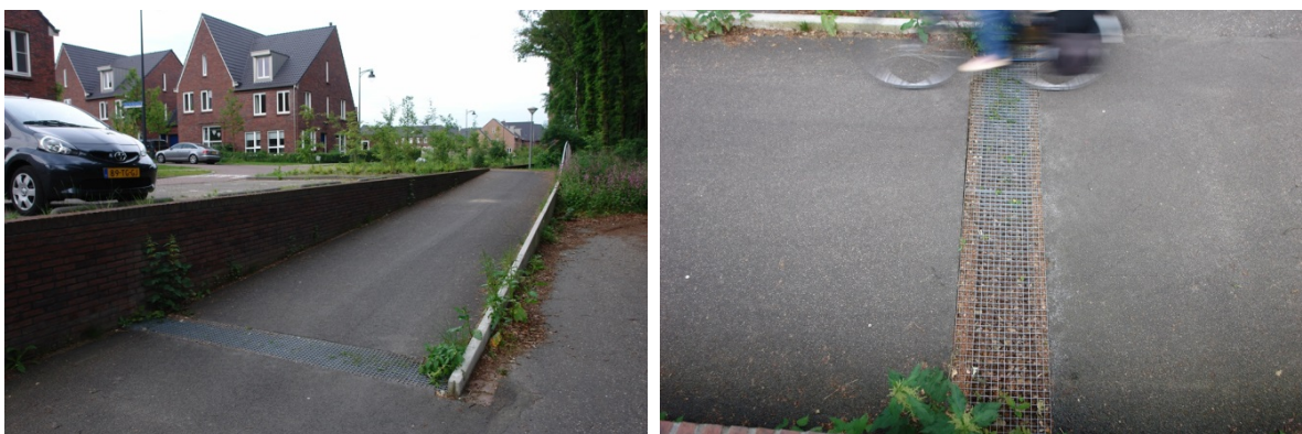
Figuur 20 Overzicht van de fietsshelling met verkeerde rooster. Gewone padden en bruine kikkers kunnen eenvoudig over het rooster heenlopen en belanden zo alsnog in de woonwijk.
