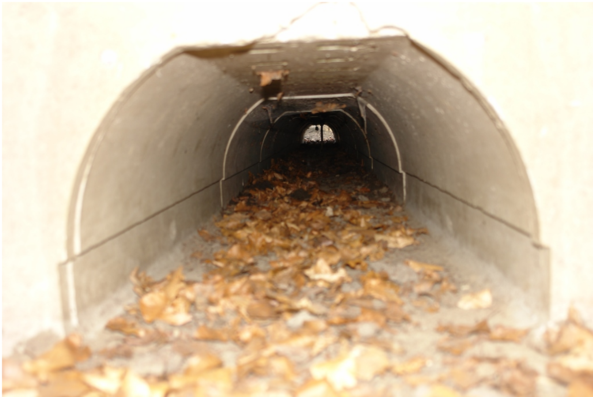
Figuur 7 Tijdens de voorjaarsmigratie van gewone padden en bruine kikkers, periode februari-april, dienen de paddentunnels vrij te zijn van obstakels en mag er ook geen water in de tunnels staan. De bovenstaande afbeelding geeft een ideale situatie weer.
