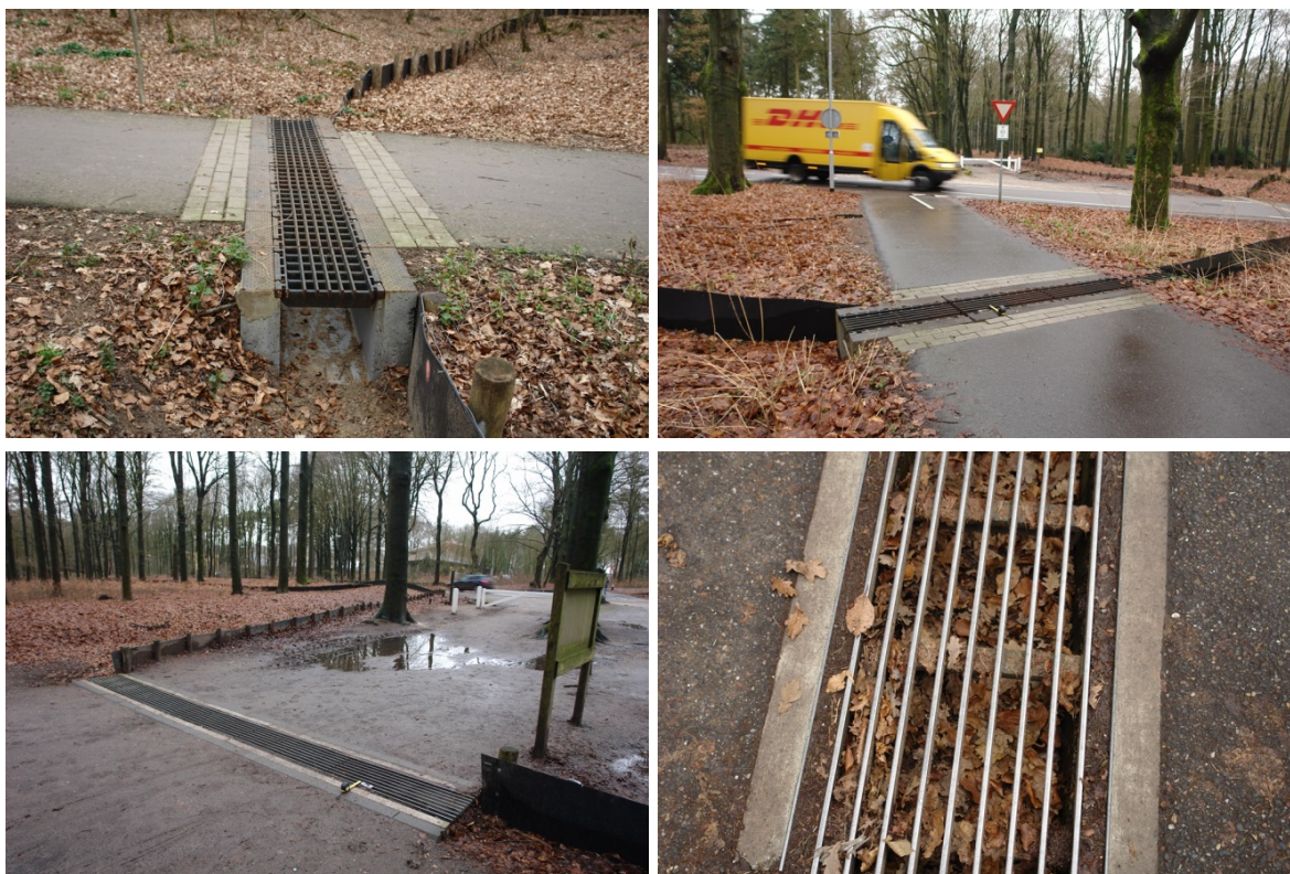
Figuur 9 De bovenste foto's laten een paddengoot type Aco SR 400 G zien. Dit type is eenmaal toegepast. Linksboven laat zien dat de toeloop en goot zelf bij voorkeur vrij van obstakels en blad moet zijn. Onder padden opvanggoot type Arfman. Dit type is vijfmaal toegepast Rechts onder laat zien dat teveel blad inval de functie belemmert.
