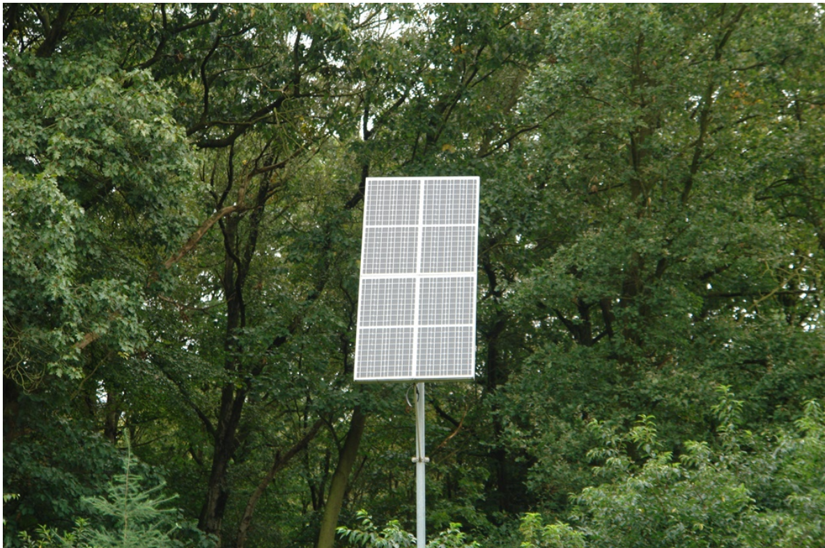
Figuur 13 Op de zuidzijde van de grote poel staat een zonnecollector (zie ook Figuur 9). Deze dient ervoor om de pomp aan te drijven die op zijn beurt er voor zorgt dat de middelste poel bij lage waterstanden wordt voorzien van water dat uit de grote poel naar de middelste poel wordt gepompt. Niet alleen de zonnecollector en de achterliggende techniek dient te functioneren, maar ook de buis die de grote poel met de middelste poel verbindt. Deze moet vrij zijn van obstakels en mag niet zijn dichtgeslibd.
