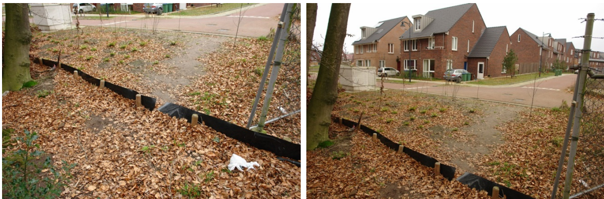
Figuur 18 Voorbeeld van een lek in het tijdelijke paddenscherm, waardoor de dieren tijdens de paddentrek alsnog op de nieuwbouw locatie terechtkomen met als risico te worden dood gereden.
