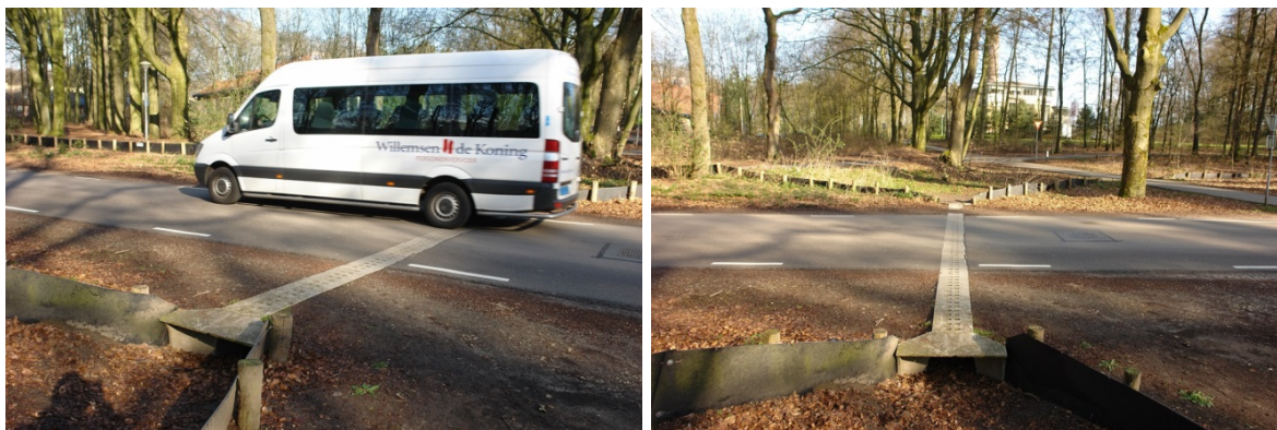
Figuur 6 Voorbeeld van de twee Aco paddentunnels die in de Horalaan zijn gelegd. Het driehoekige ingangselement is er als een los artefact tegen aan gezet.
