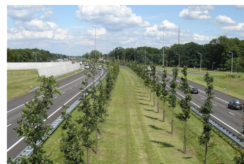
De bestaande autoweg tussen Rosmalen en Geffen is omgebouwd naar een snelweg met groenelementen. Bron: http://www.mostertdewinter.nl/projecten/pps-a59?nc=a335c22ba9d2e723b0fd33bb1bc69a1f&vnp=24
