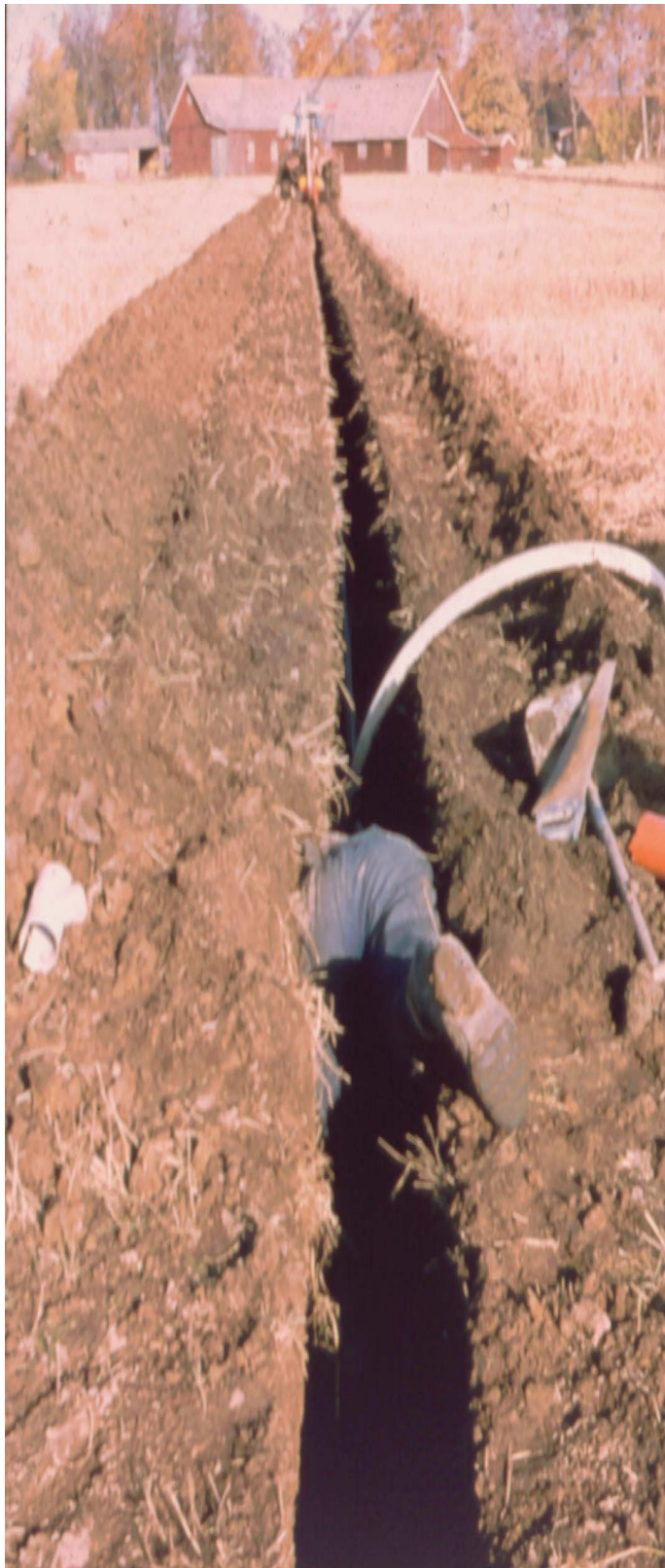
Fig 5 'Visuele' inspectie van de waterhuishouding in de ondergrond.
