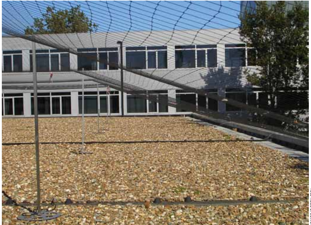
Foto 2. Een met netten overspannen dak.
