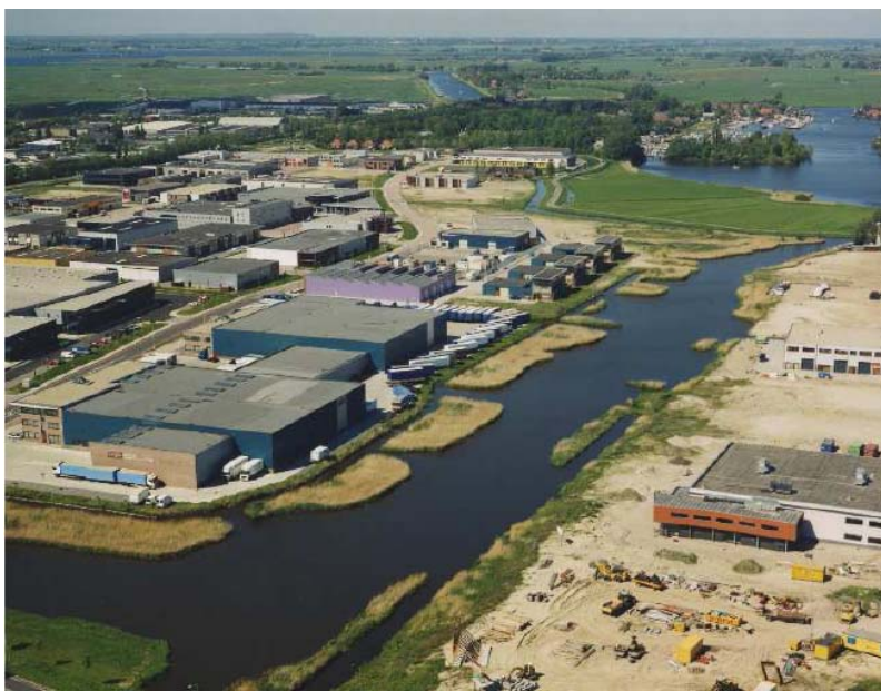
Bedrijventerrein Noorderveld in aanleg (foto: Pandion, Arnhem)
