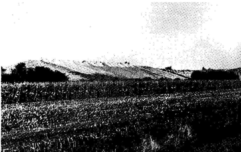
Fig. 9. Overzicht van de uitgevlakte helling waarop een laag zand van ongeveer 20 cm dikte wordt aangebracht
