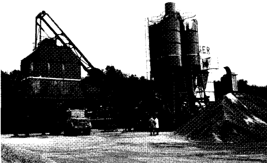
Fig. 13. Asfaltinstallatie van de fa. Snitjer te Wezuperbrug waar de menging van zand-bentoniet plaats vond
