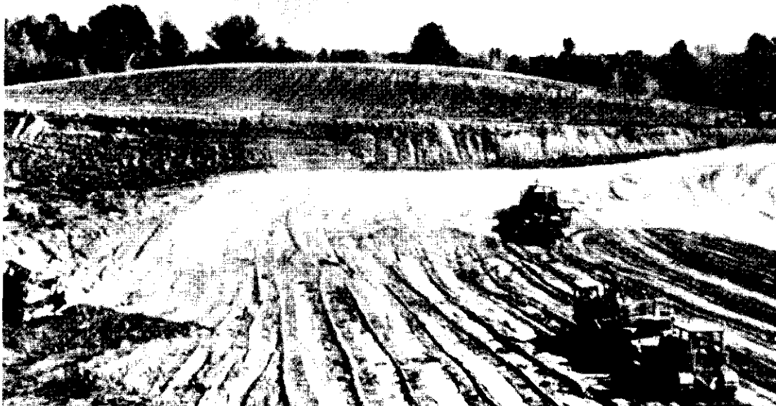
Fig. 3. Constructie van een basisafdichting bestaande uit slecht doorlatende klei (foto CECOS/CER Company, Ohio, USA)
