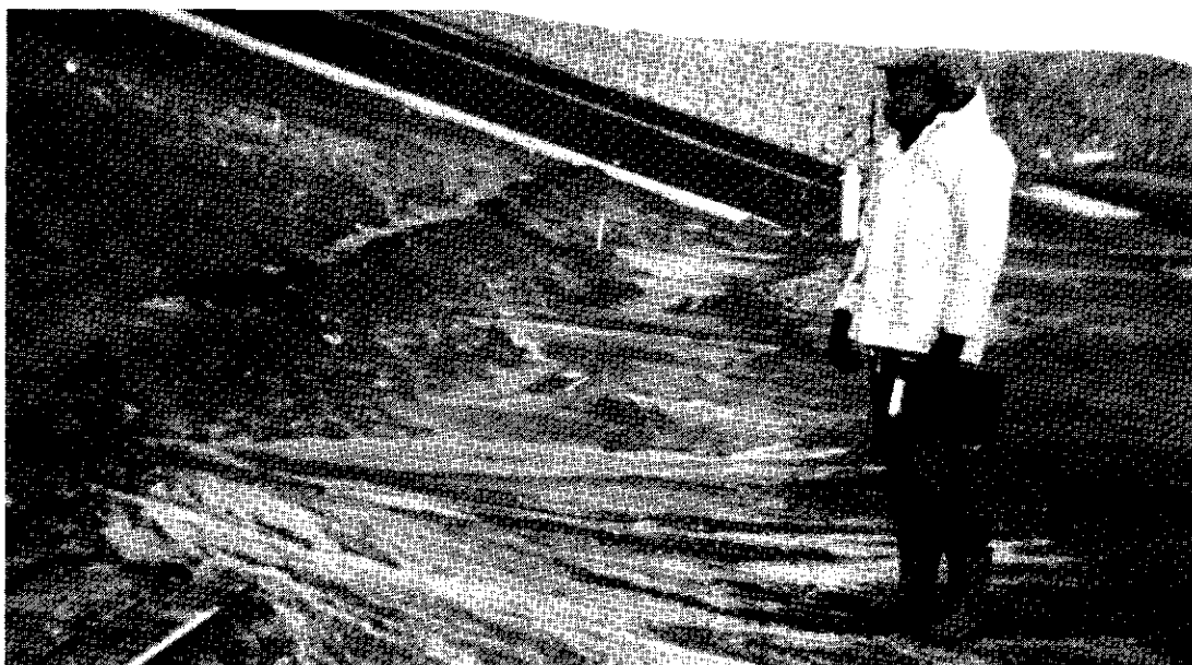
Fig. 8. Erosie van de toplaag op een onbegroeide helling
