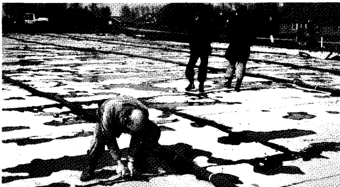
Fig. 6. Drainagesysteem op de afdichtingslaag (hier een bitumenmembraan)
